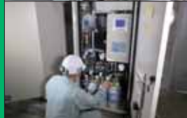
排ガス分析計のオーバーホール
